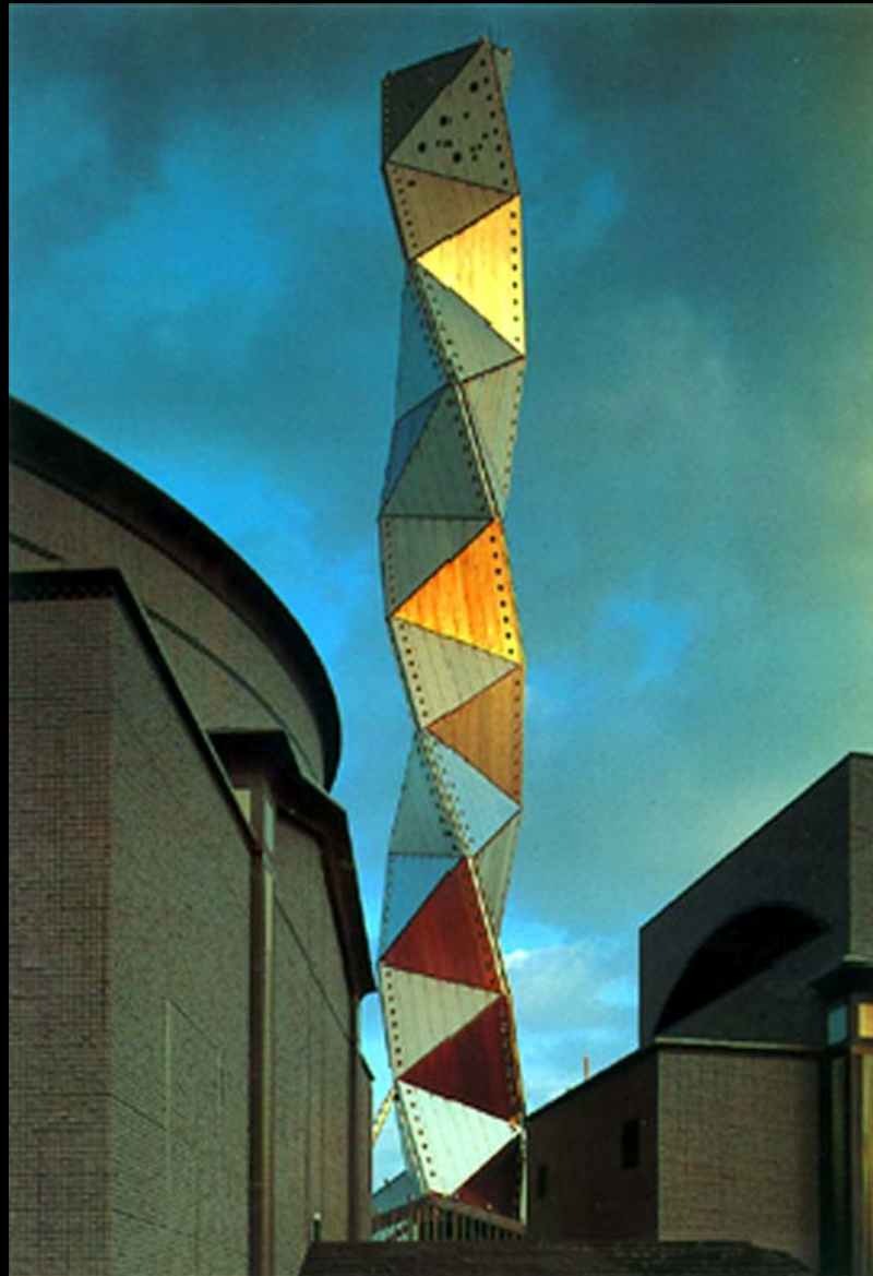
Arata Isozaki torre di Mito a Ibaraki 1990.
